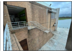
戶外樓梯欄杆拆除更新
