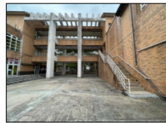
2-3樓廊道欄杆拆除更新
