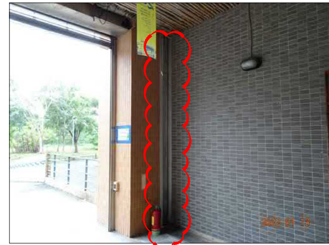
原有伸縮縫修復-2
