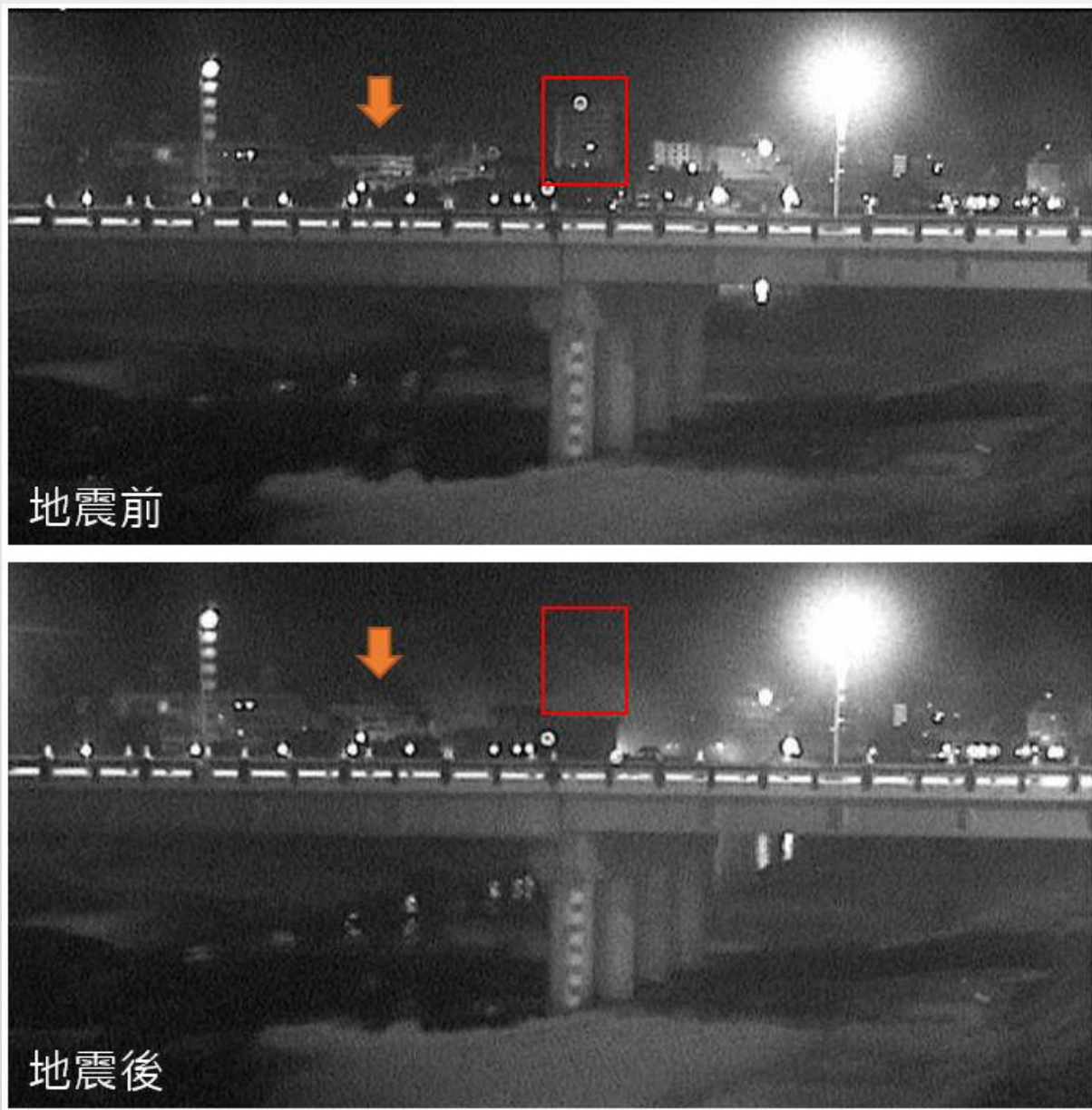
圖15. 經濟部水利署尚志橋錄影資料（每分鐘一張） 上圖為地震發生前，下圖為地震發生後影像。紅色方框為倒塌的雲門翠提大樓所在位置，地震後大樓消失於畫面中，周邊有因大樓傾覆造成的揚塵；橘色箭頭位置因地震造成該區域停電。（經濟部水利署提供）
