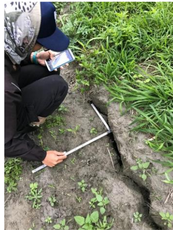
圖5. 美崙溪畔地表破裂
