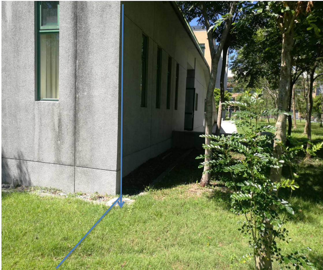
藍色線條：管路路線，屋簷盡頭往下過草地 草地挖掘後以原土復原
